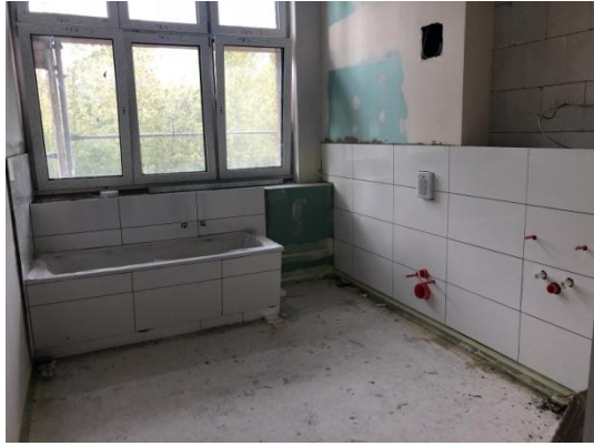
Fliesenarbeiten in den Bädern
