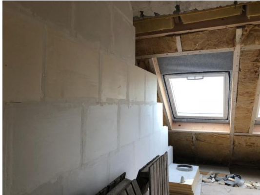
Mauerwerksarbeiten im Dachgeschoss
