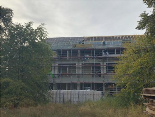
Haus 3 Dacharbeiten im Bauteil 1
