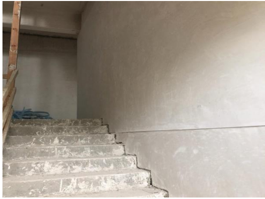
Treppenhaus wird verputzt
